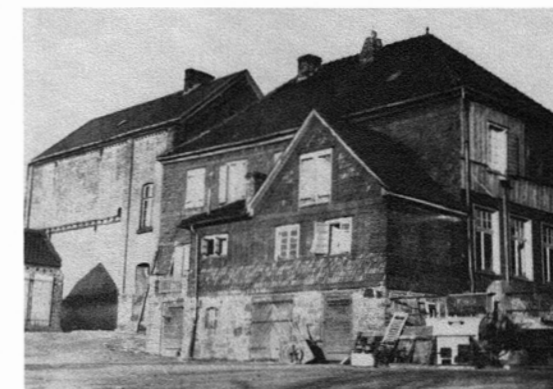
Ältestes Bechener Schulgebäude (Rückansicht)
