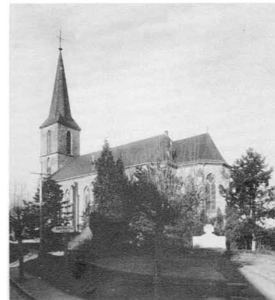
Die Kirche vor dem Abbruch
